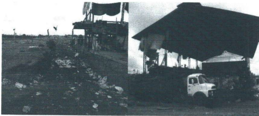
Figura 28 - Fosso e caçamba que recebe os rejeitos provenientes da triagem.
