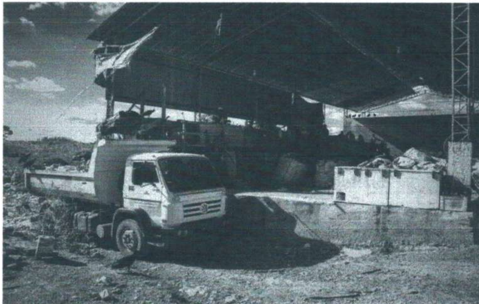
Figura 19 - Galpão de triagem.
