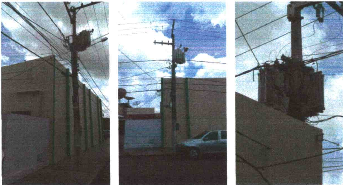
Figura 3: Foto do local onde será instalada a nova caixa de medição metálica trifásica
